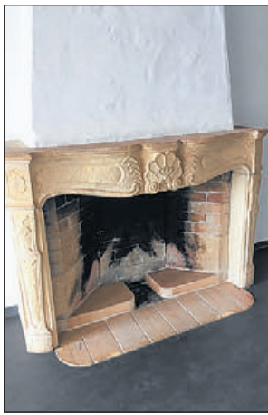
Das historische Kaminbleib erhalten, ist jedoch aktuell nicht in Betrieb.
